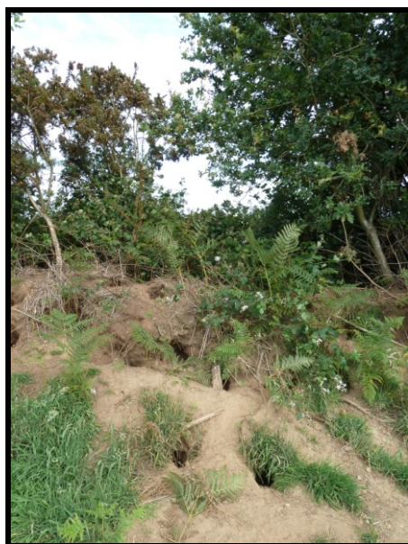
Photographie 8 : Dégradation d'un talus par des lapins de garenne (échantillon de Plumélieu, Juin 2011)
